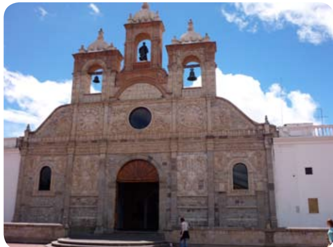
Eglise à Riobamba
