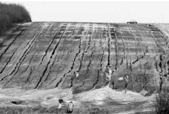
Rigoles réparties uniformément sur la pente et sédimentation au pied de la pente (Poesen, J)
